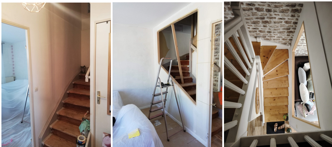
Figure 19 : Photographies des travaux effectués dans l'escalier
