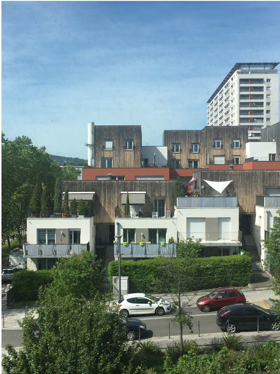
Photo 7 : Résidences avec terrasses – Carrée Anaïs – mai 2017
