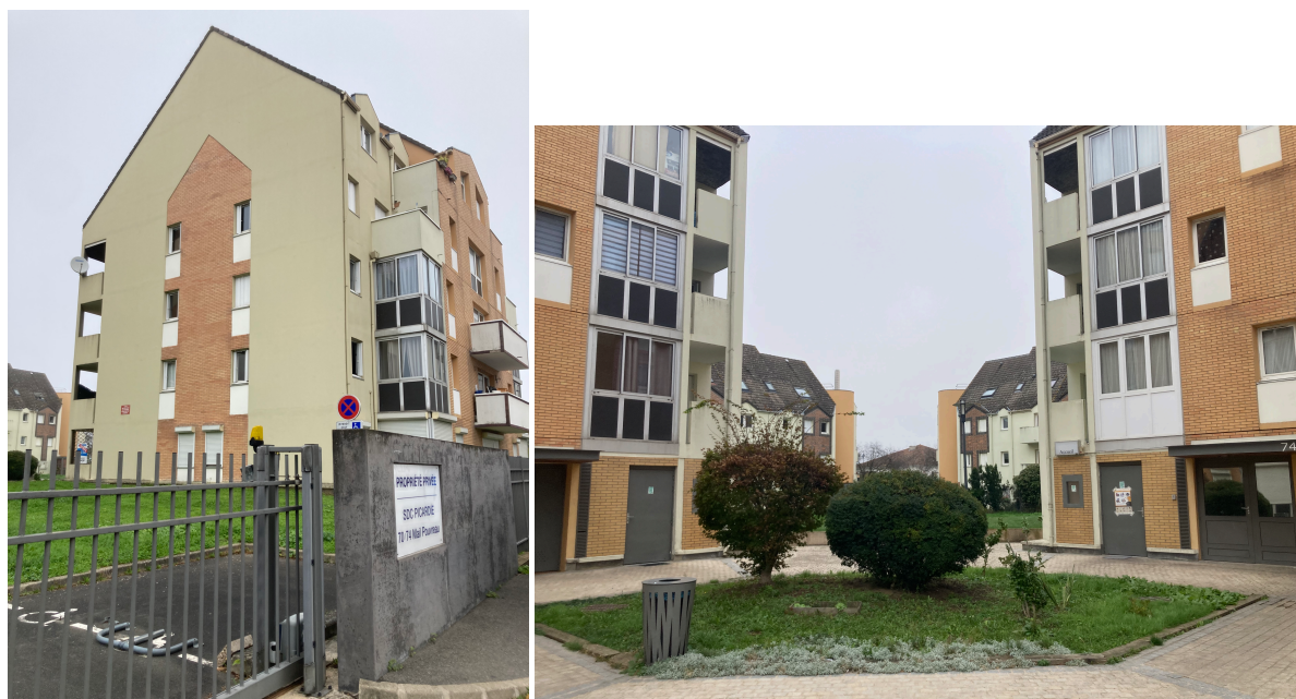
Figure 2 – Photographies de la résidence collective en QPV – Habitat des collines
