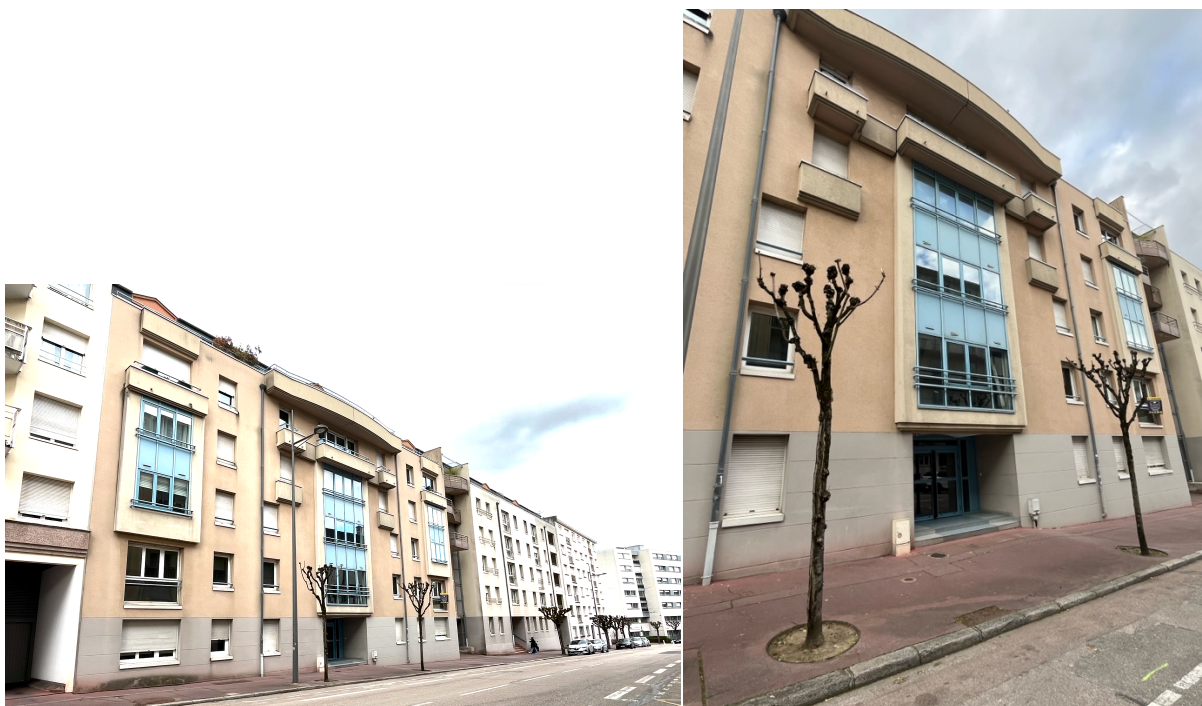
Figure 18 : Photographies des façades extérieures de la résidence
